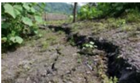
Foto 2: Grieta de tracción en la Zona 1. FUENTE: HIDROSANBATOLO, 2017.
