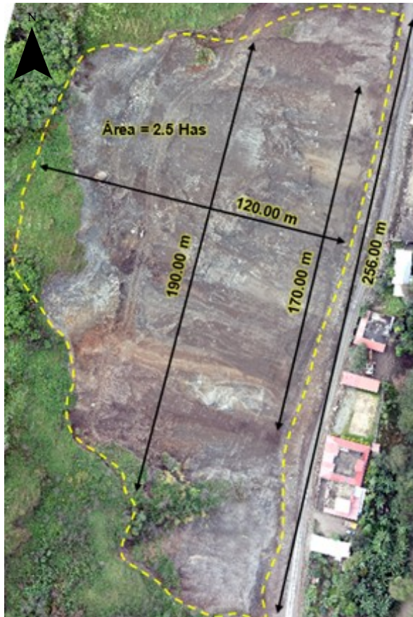
Figura 10: Morfometría del talud del deslizamiento-vista en planta.
