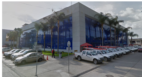
Figura 1: Imagen de la edificación E1
