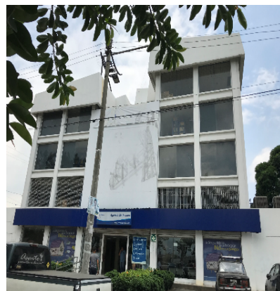
Figura 2: Imagen de la edificación E2
